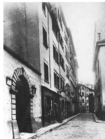
Rue Tramassac – avant
