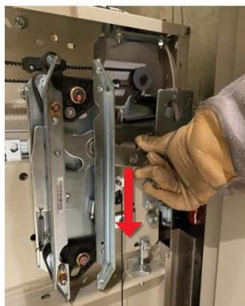
2e étape Déverrouiller le système mécanique en l'abaissant. Ouvrir en parallèle les portes.
