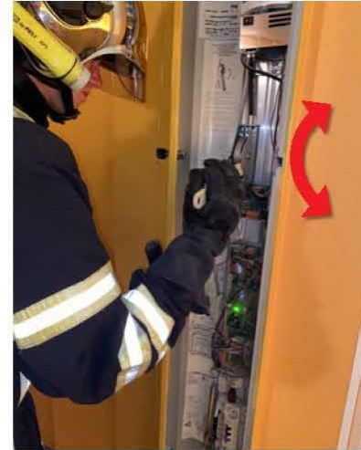
Pompage à l'aide du levier.
