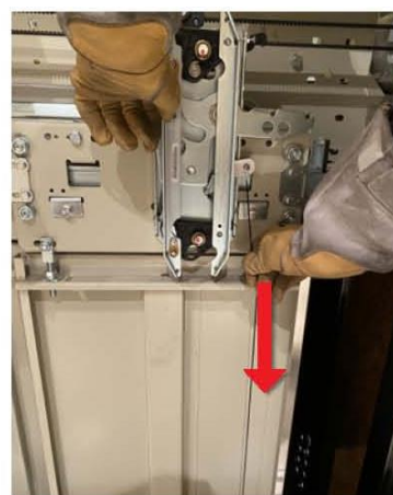
2e possibilité Déverrouiller le système mécanique en tirant sur la câblette. Ouvrir en parallèle les portes.
