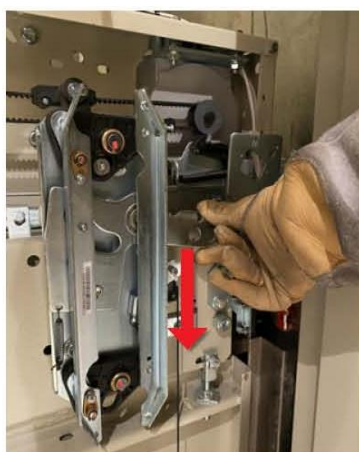
2e étape Déverrouiller le système mécanique en l'abaissant. Ouvrir en parallèle les portes.
