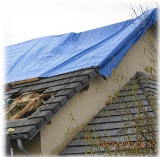
La bâche devra être placée à partir du faîte de la toiture (en haut). Lorsque plusieurs bâches sont nécessaires, il faut s'assurer de l'écoulement de l'eau en chevauchant celles-ci (celle du haut recouvrant partiellement celle du bas).
