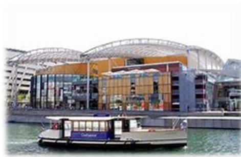
Centre Commercial Confluence - Lyon
