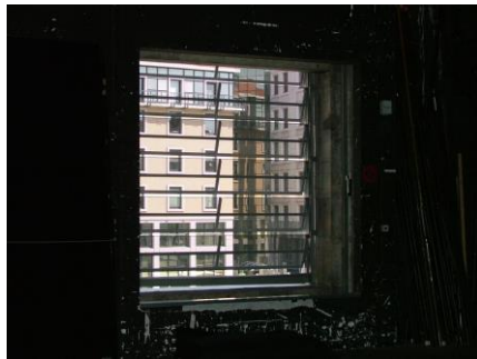
Baie d'entrée d'air
