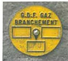
Figure 2 Plaque Repérage robinet de branchement
