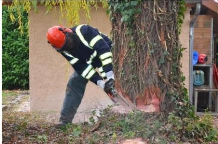
Commencer par une entaille d'une profondeur environ égale au tiers du diamètre de l'arbre sur le côté du tronc.
